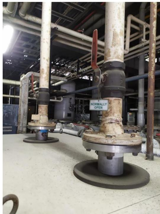
**Gambar 4.10** *Air Inlet dan Outlet pada Air Dryer*
