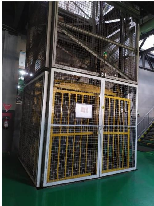
**Gambar 4.57** Cargo lift di PCB
