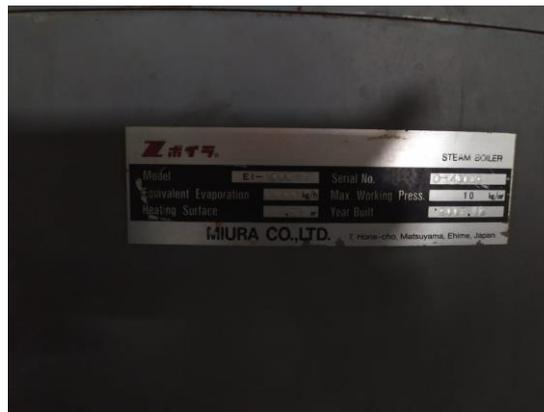
**Gambar 4.46** Spesifikasi steam boiler
