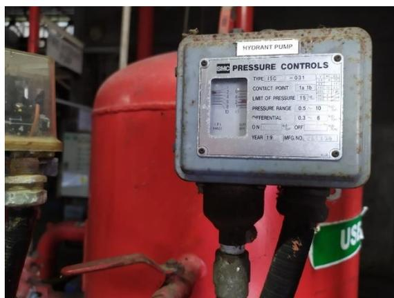
**Gambar 4.20** Spesifikasi Pompa Hidrant pada *Utility*
