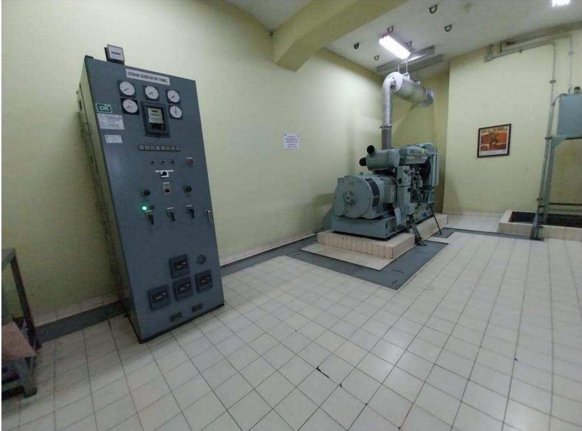
Gambar 4.2. 17 Diesel Generator
