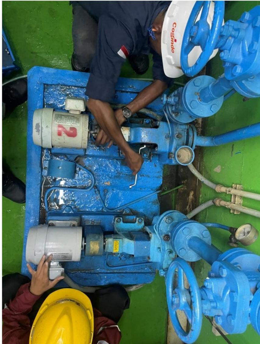
Gambar 4.2. 11 Pembersihan & Pengecekan Booster Pump
