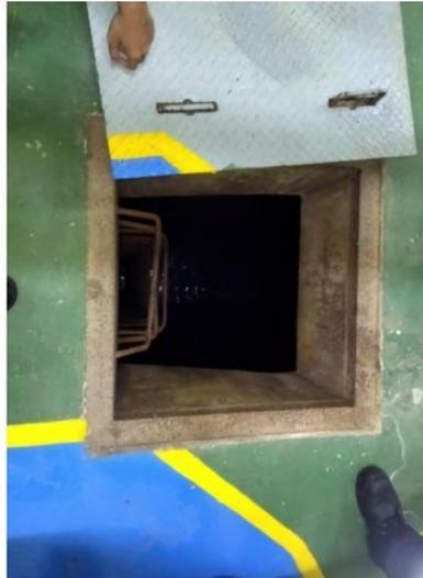
Gambar 4.3. 4 Manhole pada Drainage/Sump Pit
