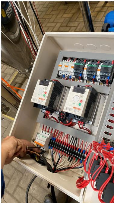
**Gambar 3. 5** Instalasi panel listrik pada mesin *spray dryer*
