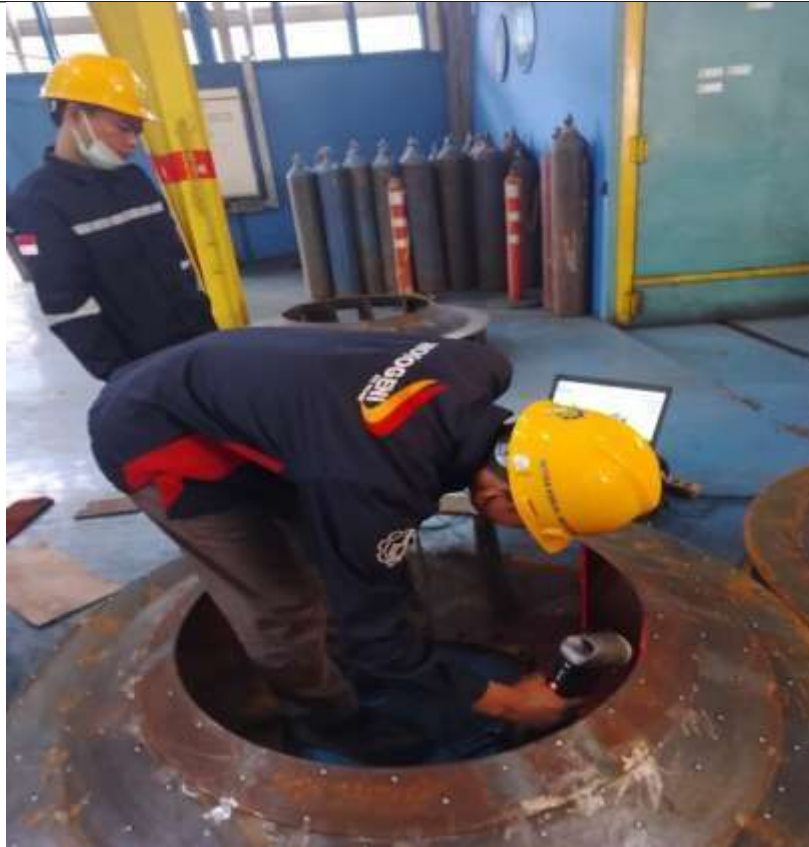
Melakukan 3D Scanning untuk Shaft PLTU
