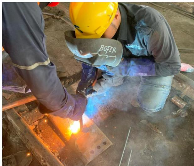
**Gambar 3.9** Mengelas mounting coupler kereta yang sudah *crack*
