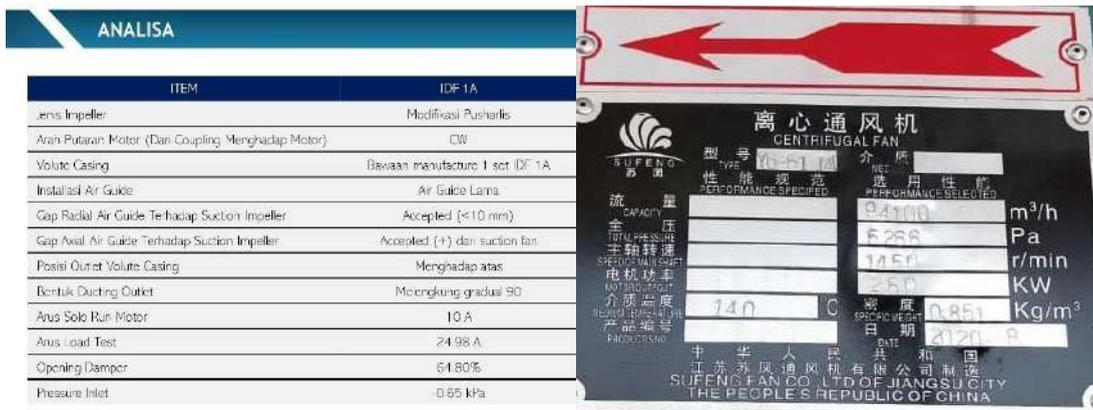
**Gambar 4.6** Data Spesifikasi *centrifugal fan*
