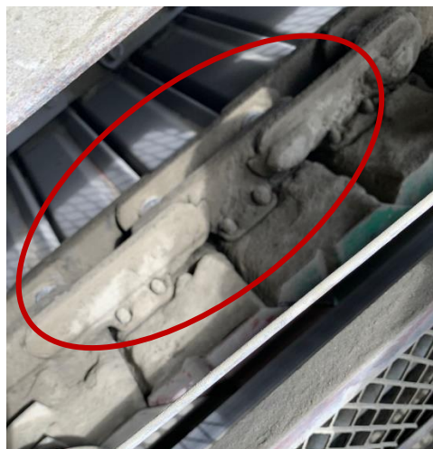
Gambar 4.7 Chain Pan Conveyor ( Sumber: Dokumen Pribadi, 2024 )
