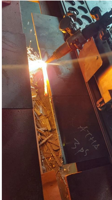
Gambar 3.5 Proses pembuatan kampuh las
