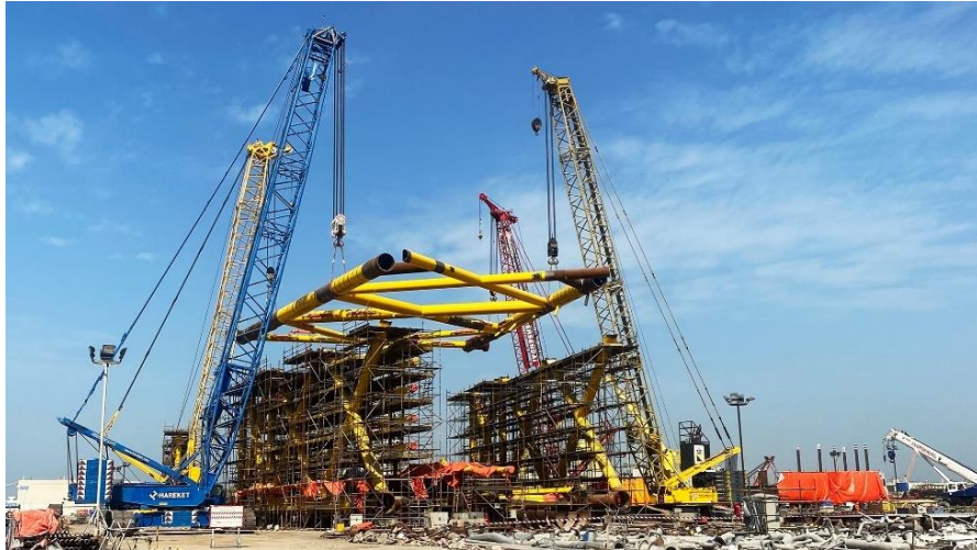
Gambar 2.4 Operasi Lifting pada Fabrikasi sebuah Struktur Jacket
