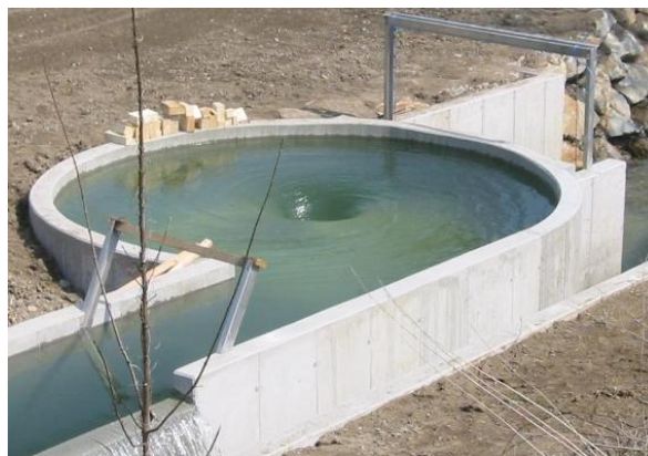
Gambar 2.4 Contoh konfigurasi GVWT dalam aliran kanal terbuka (Ersoy, 2014).
