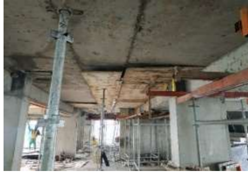
Gambar 4.20 Pembongkaran Bekisting Balok dan Plat Lantai
