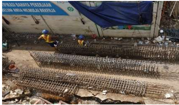
Gambar 4.6 Fabrikasi Tulangan Kolom dan Shear Wall
