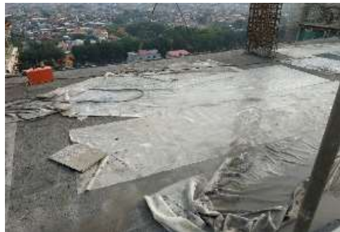
Gambar 4.21 Perawatan Beton Plat Lantai
