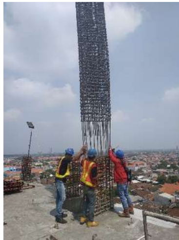
Gambar 4.7 Pemasangan Tulangan Kolom dan Shear Wall
