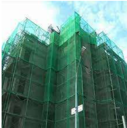
Gambar 6.2 Contoh Pemasangan Safety Net Horizontal
