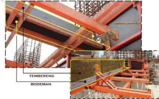
Gambar 4.15 Pemasangan Bekisting Balok
