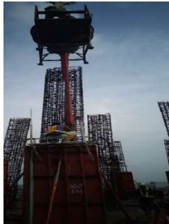
Gambar 4.14 Pengecoran Kolom dan Shear Wall
