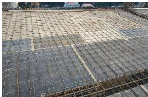
Gambar 4.16 Pembesian Plat Lantai
