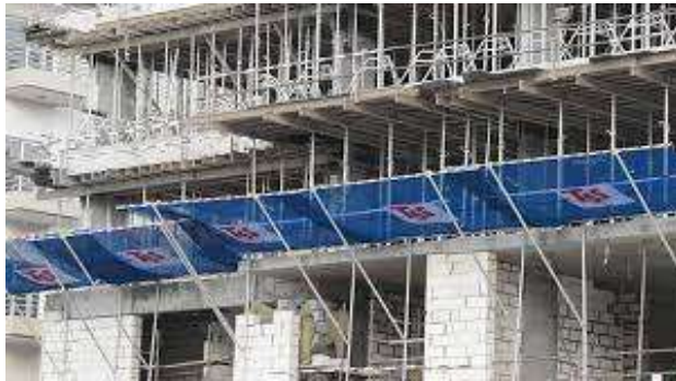
Gambar 6.1 Contoh Pemasangan Safety Net Vertikal
