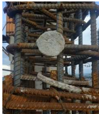
Gambar 4.9 Pemasangan Beton Decking
