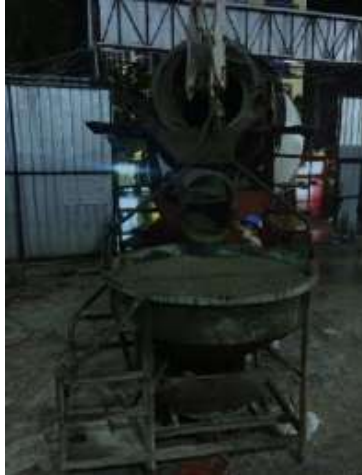
Gambar 4.13 Penuangan Beton Ready Mix ke dalam Bucket Cor
