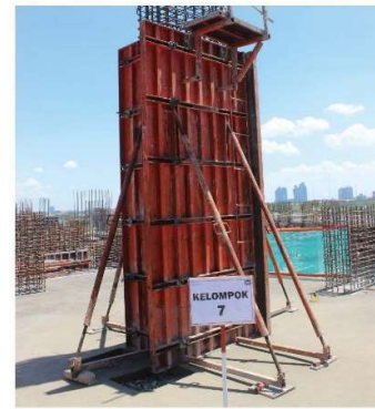
Gambar 4.12 Bekisting Kolom Dan Shear Wall Tampak Depan
