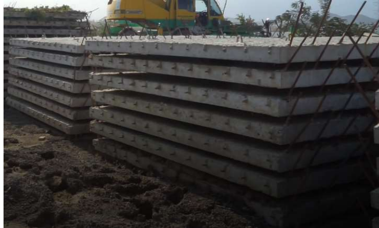
Gambar 4.10 Penumpukkan Pelat Pracetak
