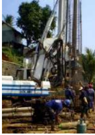
Gambar 4. 5 Pemasangan Tulangan Borepile
