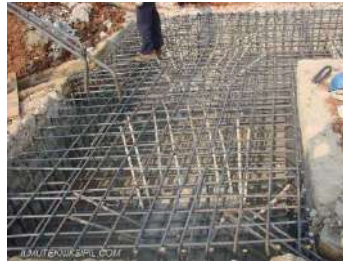
Gambar 4. 10 Pekerjaan Penulangan Pilecap
