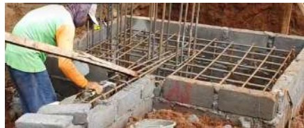
Gambar 4. 9 Pekerjaan Bekisting Pile Cap (Sumber : https://www.ilmutekniksipil.com/teknik-pondasi/metode-pelaksanaan-pile-cap )
