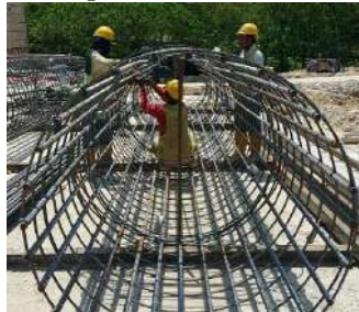
Gambar 4. 4 Fabrikasi Tulangan Borepile
