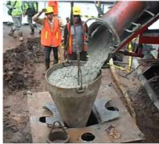
Gambar 4. 6 Pengecoran Borepile
