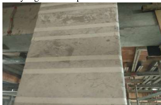
Gambar 5. 4 Marking Area Beton yang Akan Dilapisi CFRP
