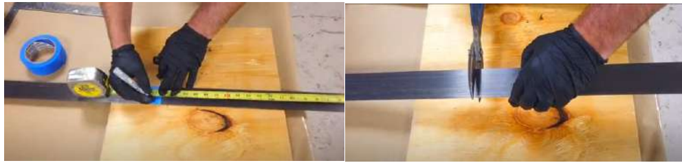
Gambar 5. 5 Pengukuran dan Pemotongan CFRP
