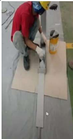
Gambar 5. 7 Proses Pelapisan Lembaran CFRP dengan Epoxy
