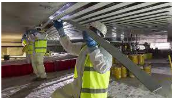
Gambar 5. 8 Proses Pemasangan Lembaran CFRP pada Beton
