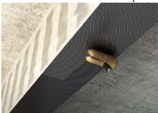
Gambar 5. 9 Proses Menekan CFRP Menggunakan Roller
