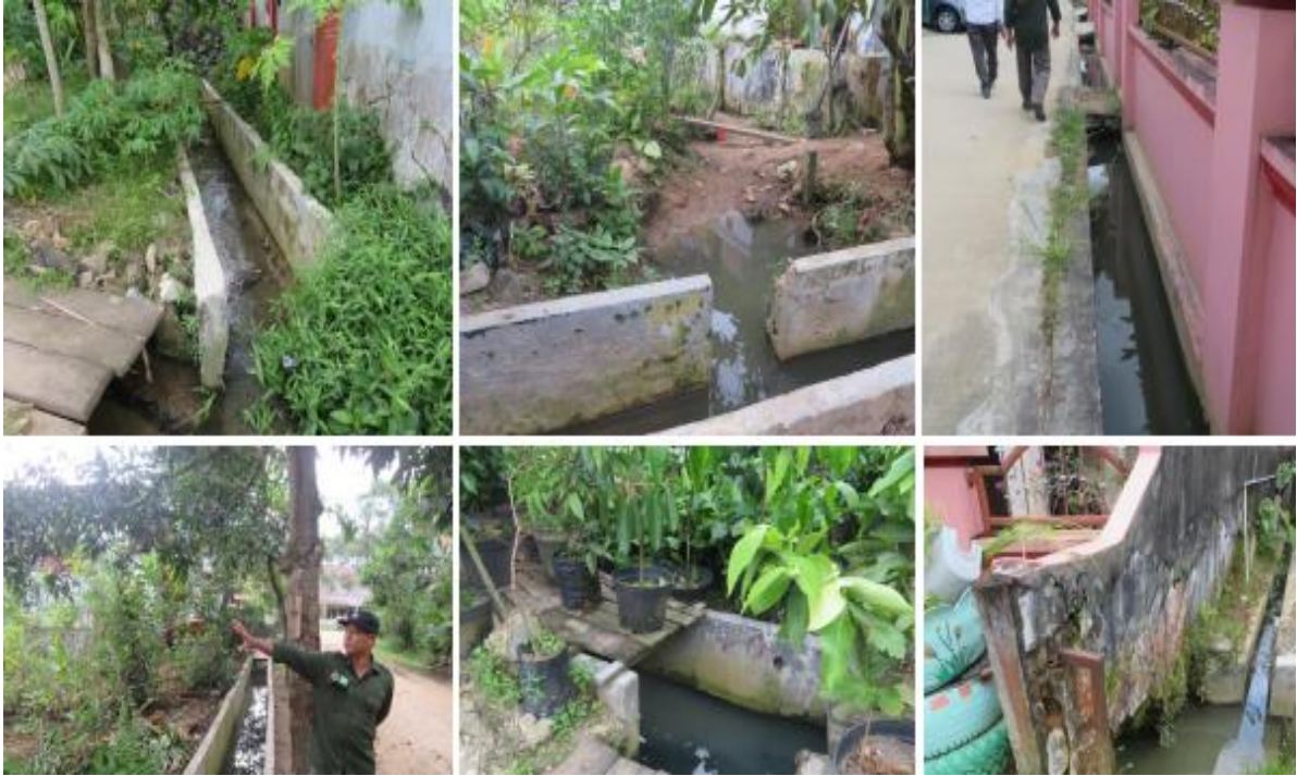
Gambar 2. 20 Kondisi Eksisting Parit
