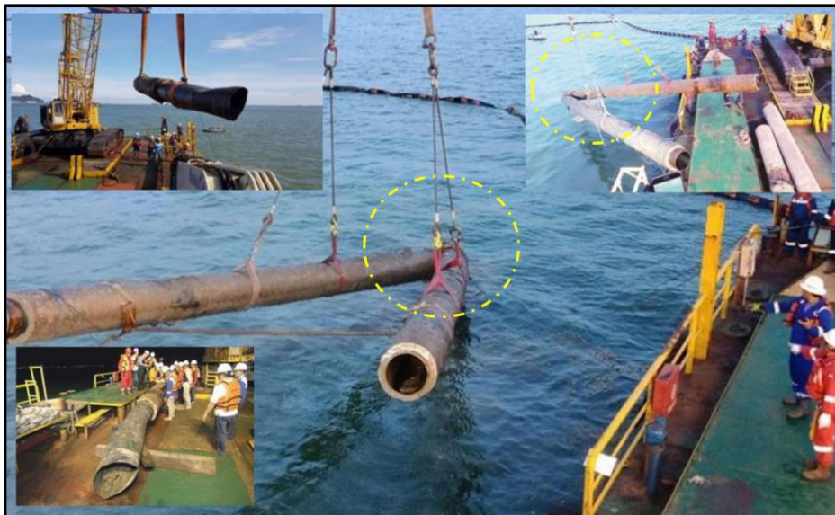
Gambar 4.7 Pengangkatan Patahan Pipa Pertamina dari Dasar Laut
