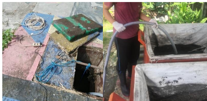
Gambar 3. 3 Proses Pengisian Lumpur Pada SD
