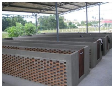
Gambar 4.21 Struktur Bata Berongga
