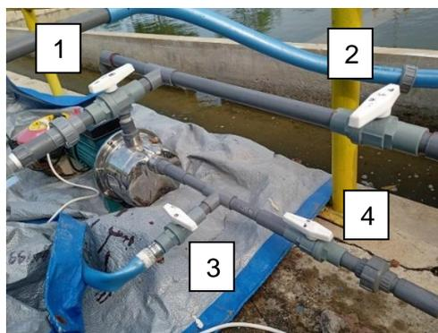
Gambar 3 8 Katup *Backwash* dan Filtrasi
