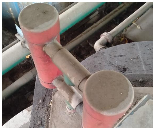
Gambar 2. 7 Absorber Bau Pada Biofilter
