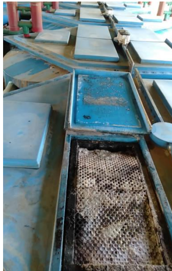
Gambar 4. 3 Peletakkan Media Pada Reaktor
