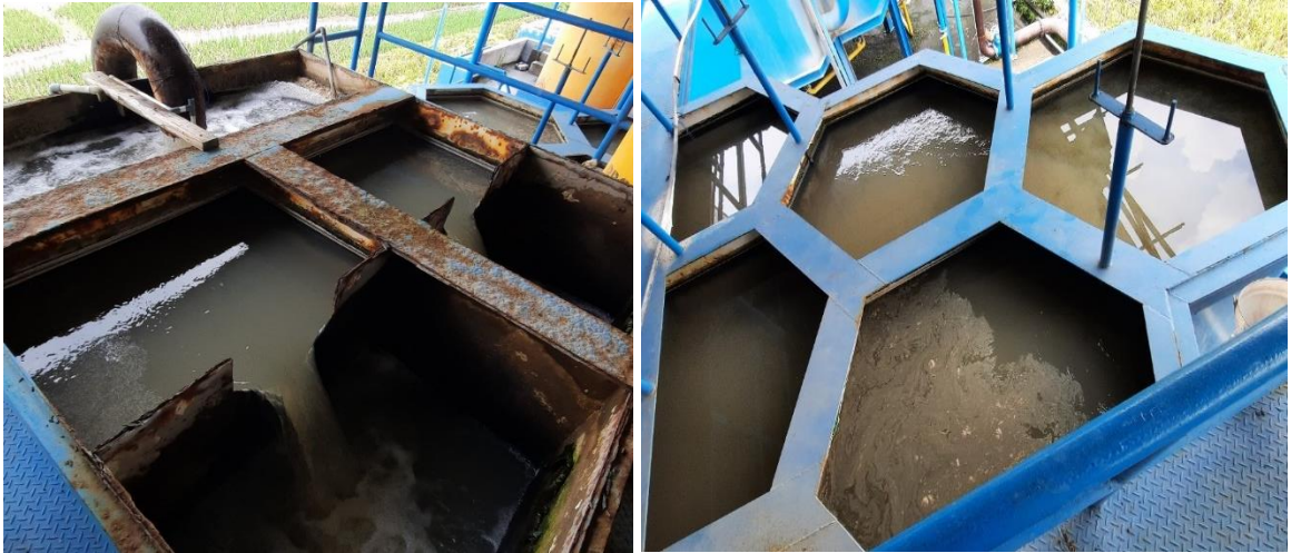
Gambar Unit Koagulasi-Flokulasi IPA Siwalanpanji
