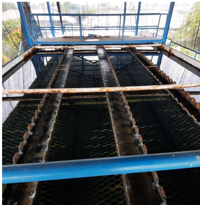
Gambar Unit Sedimentasi IPA Siwalanpanji
