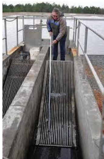
Gambar 2.3 Bar screen manual dan pembersihannya
