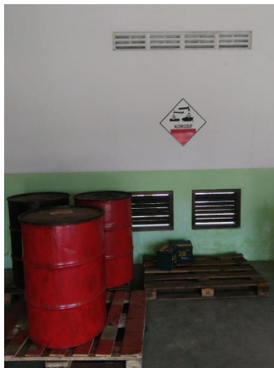
Gambar 4.24 Peletakan Accu Bekas Tanpa Kemasan
