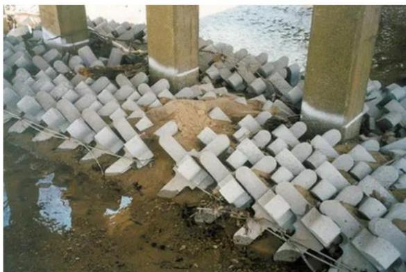
**Gambar 2.3** Aplikasi beton a-jack dalam struktur pelindung pantai (Green, 2000)
