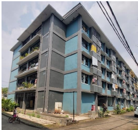
Gambar 4.9 Bangunan Blok C Rusunawa Sumur Welut
