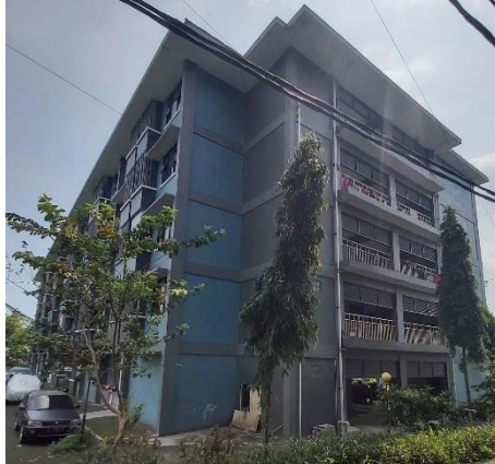
Gambar 4.8 Bangunan Blok B Rusunawa Sumur Welut
