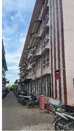
Gambar 4.3 Bangunan Blok B Rusunawa Keputih
