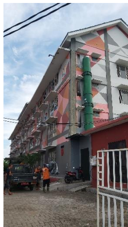
Gambar 4.5 Bangunan Blok D Rusunawa Keputih
