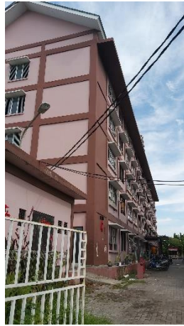
Gambar 4.4 Bangunan Blok C Rusunawa Keputih
