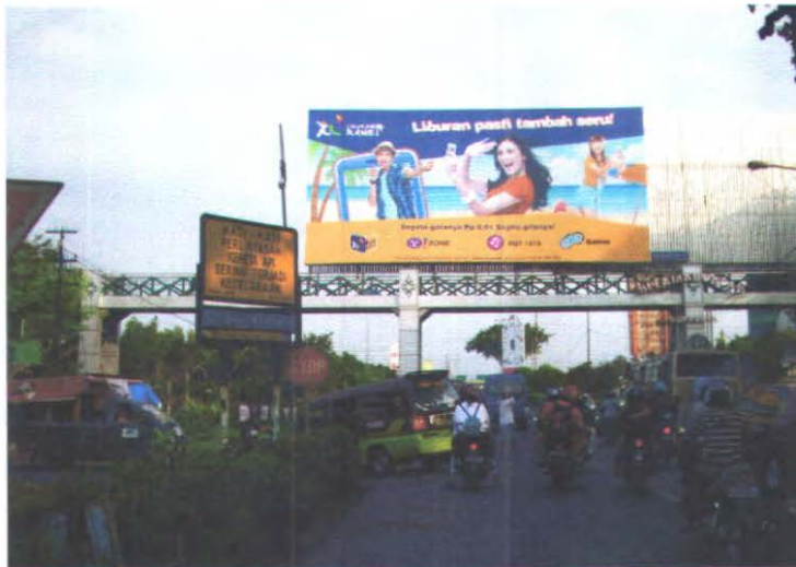
Gambar b. Jembatan Penyebrangan Graha Pangeran
