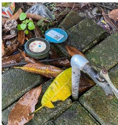
**Gambar 4. 3 Contoh Temuan Meter Air pada Pelanggan yang Telah Menggunakan Pembacaan Barcode**
