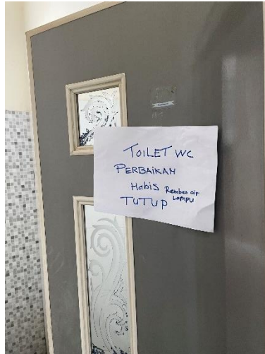
Gambar 4. 3 Pemberitahuan perbaikan pada alat plambing.
