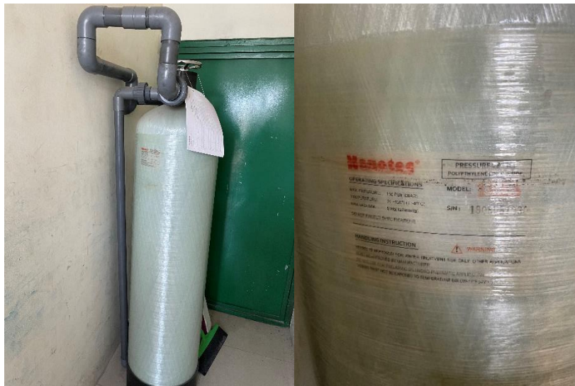
Gambar 4. 4 Tabung Filter Gedung Utama PT PCS.
