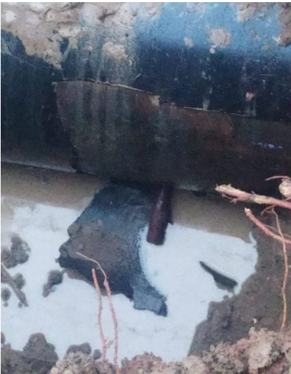
Pemasangan klem sementara pada pipa bocor
