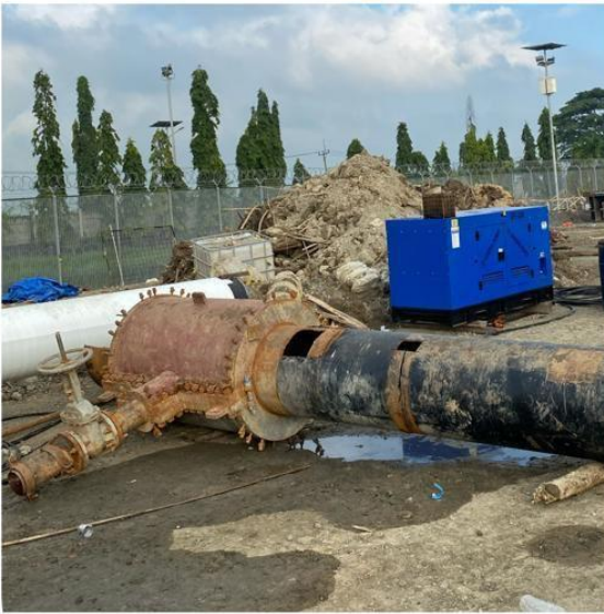
Proses pergantian pipa yang bocor
