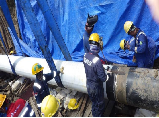
Proses pergantian pipa yang bocor
