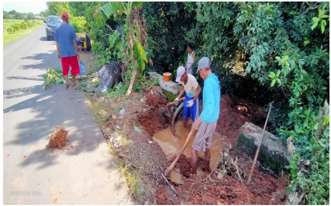
Proses pergantian pipa pada kebocoran yang terjadi
