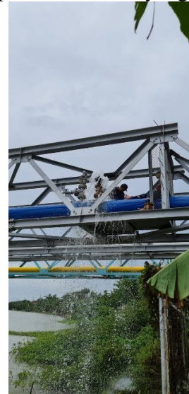
Contoh kebocoran pipa pada jalur transfer
