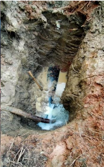
Pemasangan klem sementara pada pipa bocor
