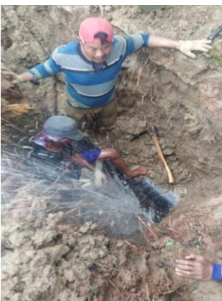
Pemasangan klem sementara pada pipa bocor
