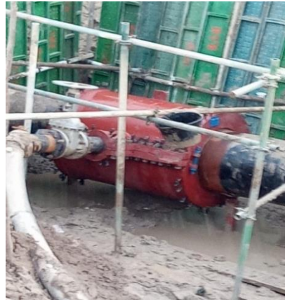
Proses pemasangan klem pada kebocoran pipa
