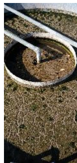
Gambar 2. 2 Kondisi Bak Sedimentasi Eksisting yang mengalami Sludge Bulking
