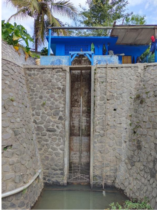
Gambar 2.6 Unit Intake IPAM Tegal Besar Sumber: Dokumentasi Pribadi
