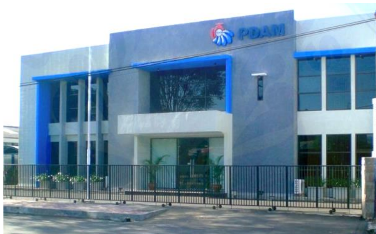
Gambar 2.5 Gedung Kantor PDAM Jember, Jl. Trunojoyo No. 73 Jember Sumber: Perusahaan Daerah Air Minum Kabupaten Jember
