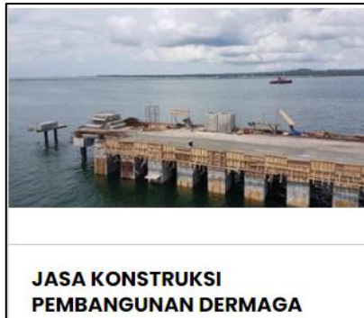
Gambar 2. 16 Konstruksi Pembangunan Dermaga ( http://www.ajg.co.id/ )
