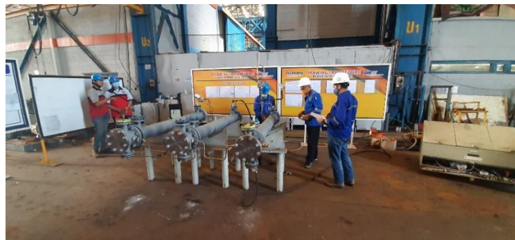
Gambar 5.2 pelaksanaan pengujian hydro test
