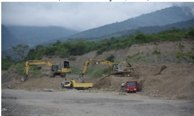
Gambar 5.27 Pengerukan Material Timbunan dengan Excavator (Sumber: sumatra.bisnis.com)
