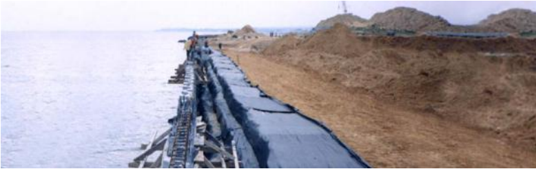
Gambar 5.34 Pekerjaan Pemasangan Geotextile (Sumber: geosistem.co.id)
