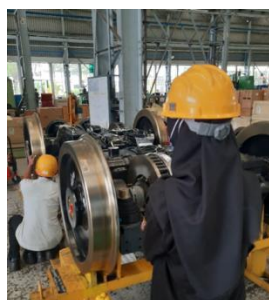
Mengamati proses pemasangan bagian-bagian bogie
