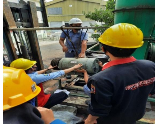
Perawatan motor listrik blower
