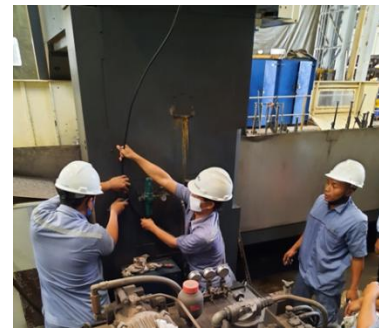
Perbaikan selang oli pada mesin cnc frais
