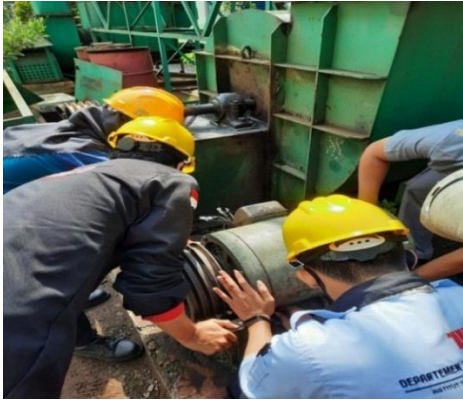
Perawatan motor listrik blower
