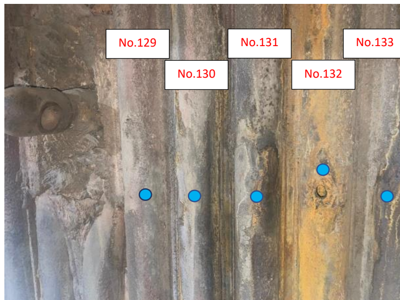
Gambar 4.8 Titik pengukuran thickness elevasi 29.8 mdpl area sootblower IR20
