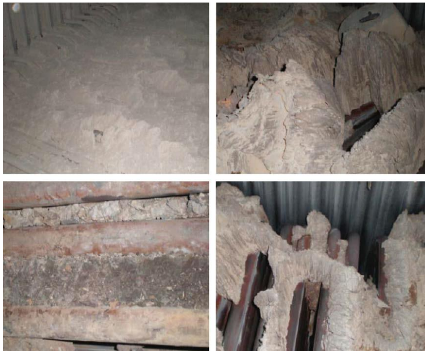
Gambar 2.13 Heavy clinkers menutupi wilayah primary superheater dan mengisi ruang kosong antara panel, dan berpotensi localized overheating di beberapa spot yang tidak tertutup [25]
