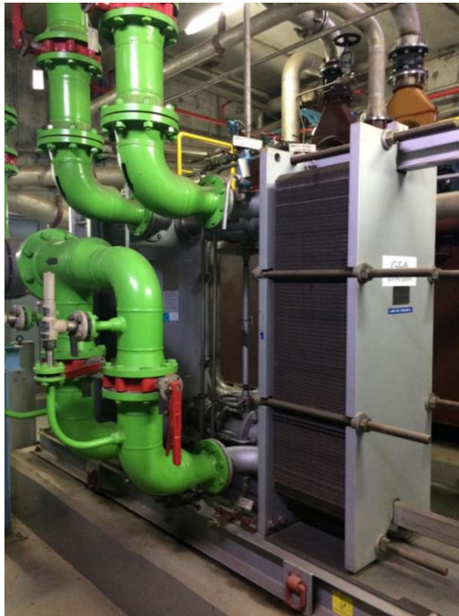
Gambar 3.5. Lube oil cooler pada blok 5 UP Muara Tawar.
