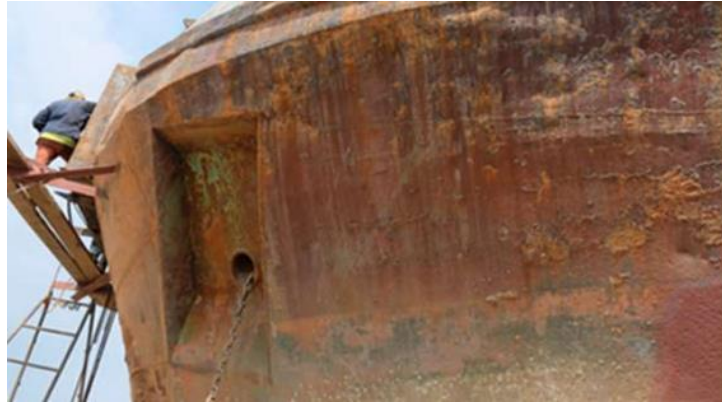
Gambar 2.1 Uniform Corrosion (Nurdiansyah, 2021)
