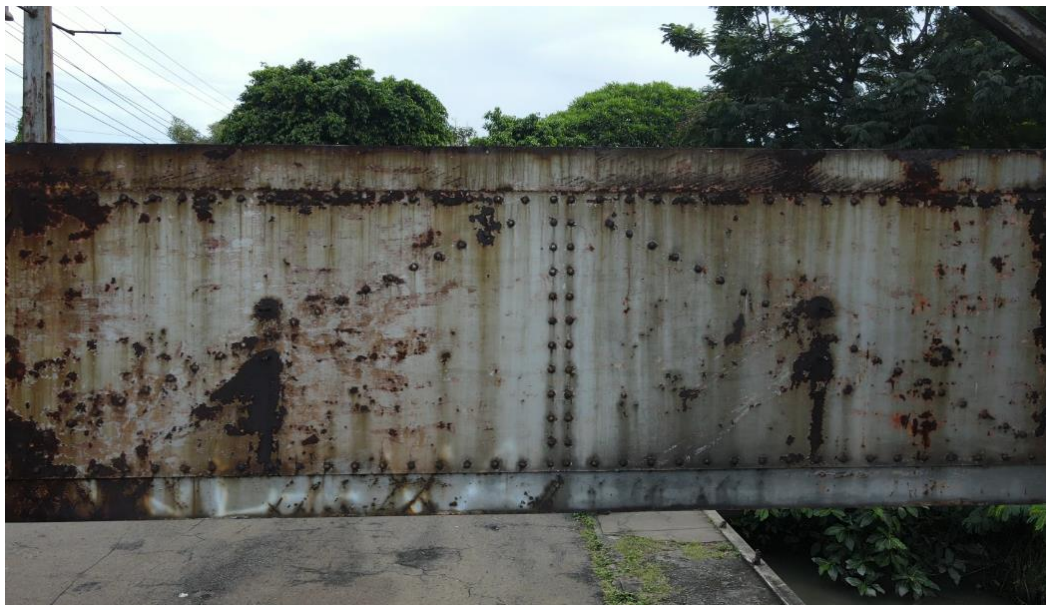
Gambar 3.5 Bagian Jembatan yang Dilakukan Pengujian (Dokumen Pribadi)
