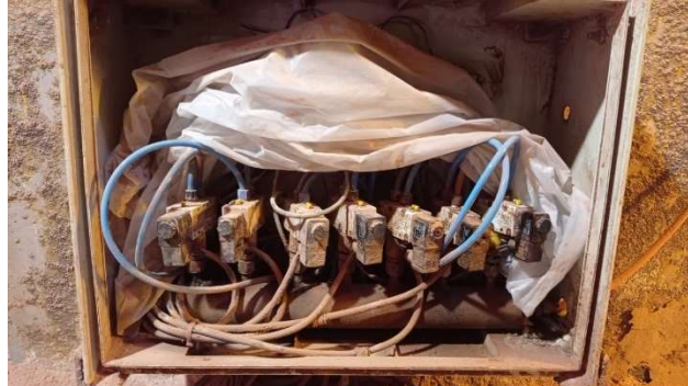
Gambar 3.5 Selenoid Valve (Sumber: Dokumentasi Perusahaan)
