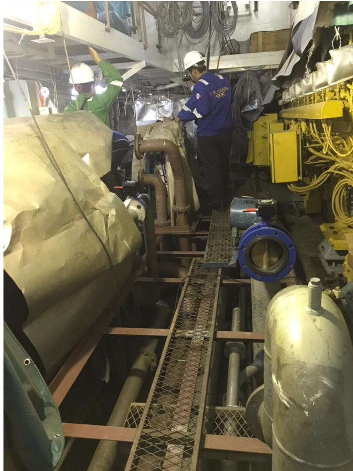
Lampiran 14: Dokumentasi Instalasi Perpipaan pada Engine Room Kapal Bantu Rumah Sakit
