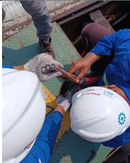
Melakukan Pengecekan dan pengkulitan kabel karena kabel terindikasi rusak
