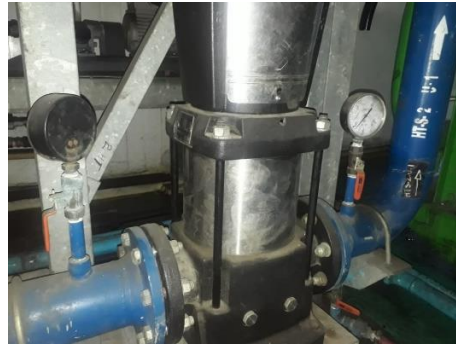
Gambar 4. 28 Pompa Sentrifugal High Temperature pada PLTMG PT. LEGI (Sumber:Dokumentasi Pribadi)
