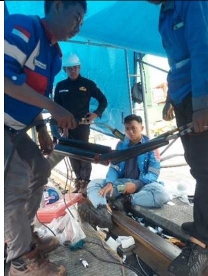
Melakukan Jointing Kabel Container crane yang rusak
