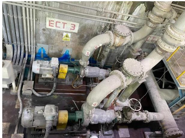
**Gambar 4.7** Foto Aktual Pompa ECT
