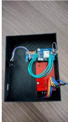
Gambar 4.30 Pemasangan Komponen (Sumber: Dokumen Pribadi)
