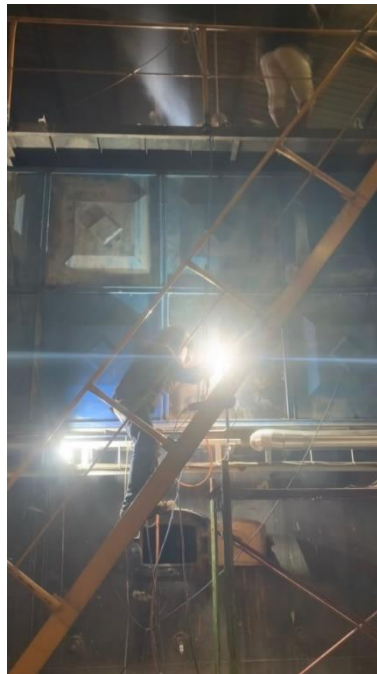
Gambar 4. 21 Finishing (Sumber: Dokumentasi Pribadi)
