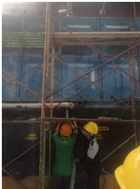
Gambar 4. 39 Penanganan Awal Kebocoran (Sumber: Dokumentasi Pribadi)
