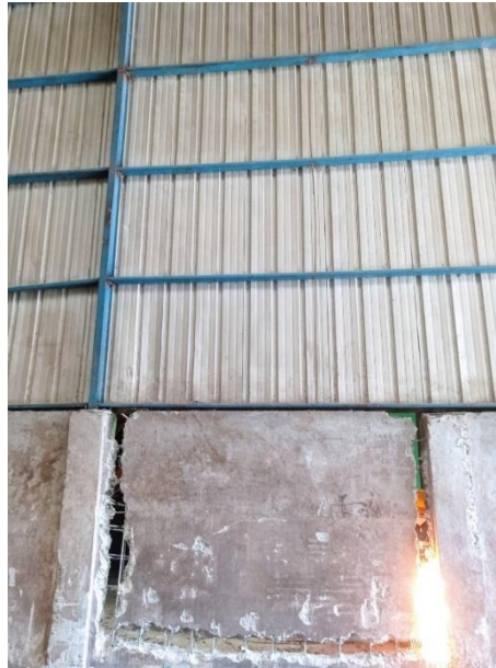
Gambar 4. 13 Pekerjaan Pembongkaran Dinding Stock Pile (Sumber: Dokumentasi Pribadi)
