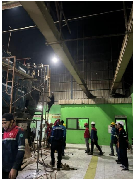
Gambar 4. 43 Pemeriksaan Kebocoran Boiler
