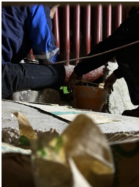
Gambar 4. 42 Repair Kebocoran Boiler (Sumber: Dokumentasi Pribadi)
