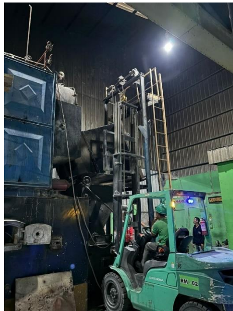
Gambar 4. 18 Instalasi Hopper (Sumber: Dokumentasi Pribadi)
