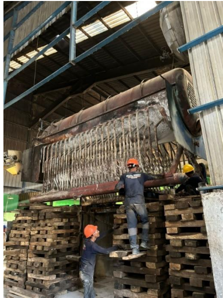
Gambar 4. 14 Pekerjaan Dismantle Boiler Existing (Sumber: Dokumentasi Pribadi)
