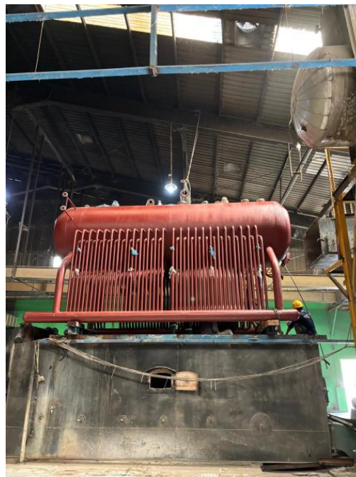
Gambar 4. 15 Pekerjaan Erection Boiler Baru (Sumber: Dokumentasi Pribadi)
