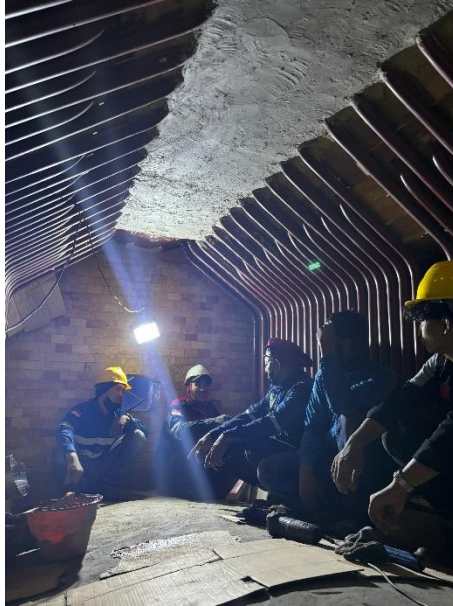
Gambar 4. 41 Area Eksekusi Pekerjaan Repairing (Sumber: Dokumentasi Pribadi)
