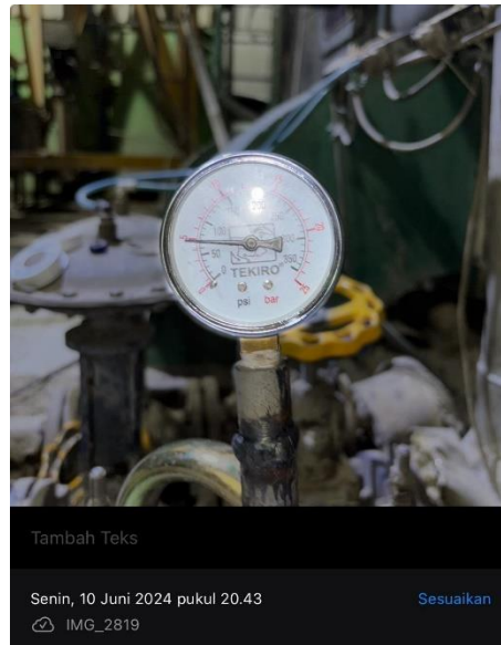
Gambar 4. 32 Pressure 5 Bar (Sumber: Dokumentasi Pribadi)
