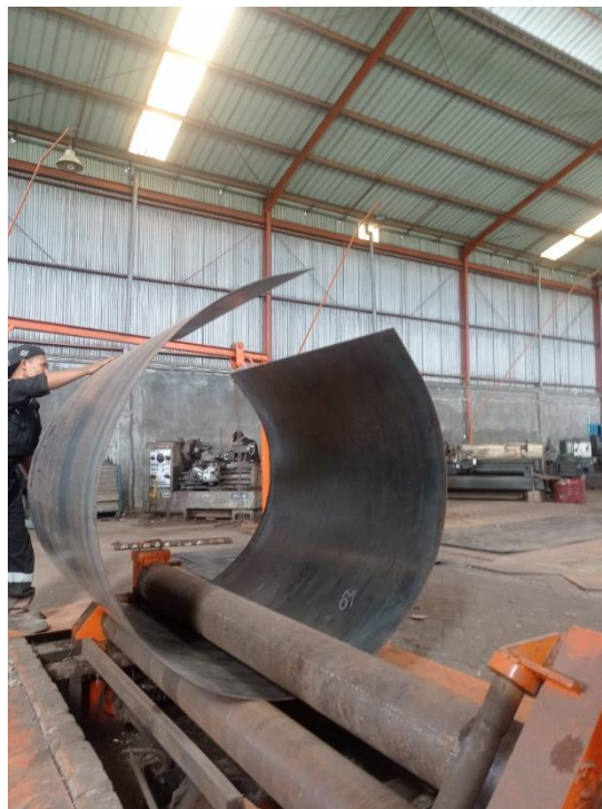
Gambar 2. 7 Pekerjaan Pengerolan (Sumber: Dokumentasi Pribadi)
