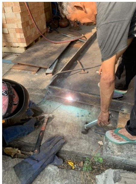
Gambar 4. 12 Pekerjaan Fabrikasi Coal Gate (Sumber: Dokumentasi Pribadi)
