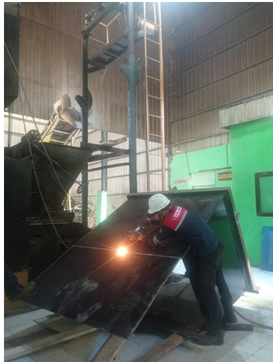
Gambar 2. 5 Pekerjaan Fabrikasi Ducting,Hopper Railing (Sumber: Dokumentasi Pribadi)
