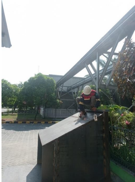
Gambar 4. 11 Pekerjaan Fabrikasi Hopper (Sumber: Dokumentasi Pribadi)
