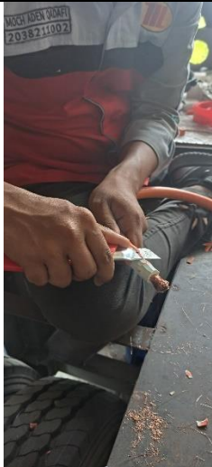
Memotong dan memasang konektor motor kontroler
