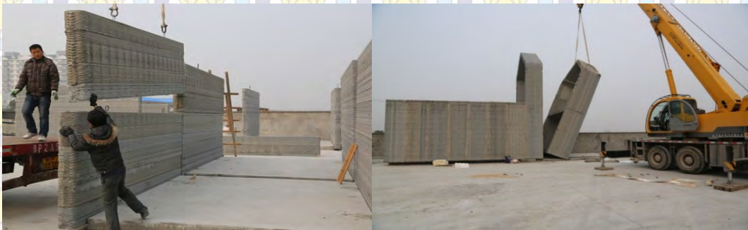
Gambar 4.14 Proses Assembly Dinding Tembok Bangunan (3ders.org)
