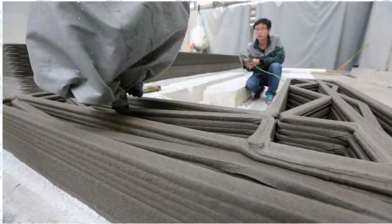
Gambar 4.13 Proses Printing Dinding Tembok Bangunan (3ders.org)
