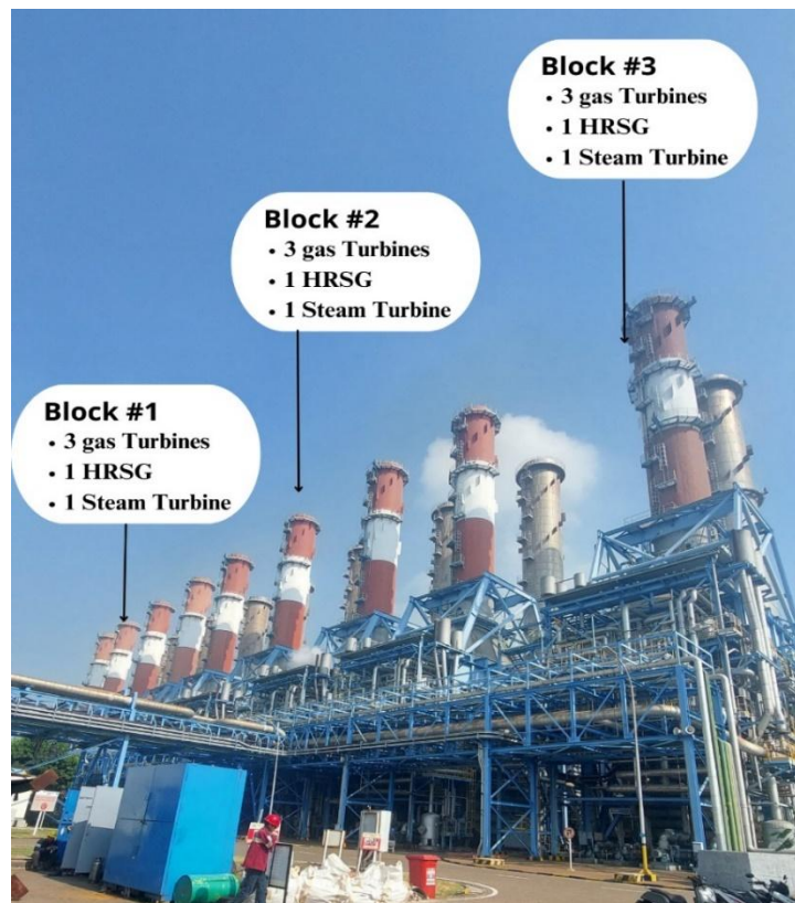
Gambar 4. 1 Konfigurasi Pembangkit PLTGU UP Gresik
