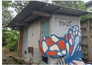
Gambar 4. 17 Toilet Umum Sumber : Observasi Lapangan, 2025
