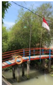
Gambar 4. 9 Kondisi Jembatan di Desa Ekowisata
