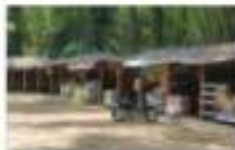
Gambar 4.96 Bangunan kios yang tidak digunakan
