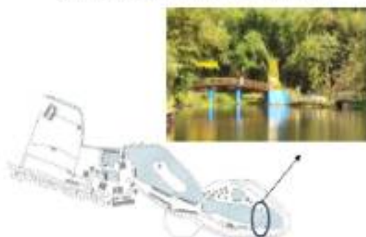
Gambar 4.197 Jembatan di sisi timur taman
