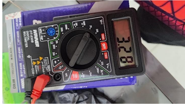
Gambar 3.5 Pengukuran Tegangan Baterai
